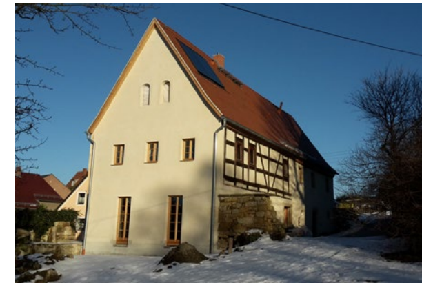
Denkmalgerechte Sanierung zu 100 % erfüllt!
