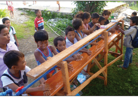
Neue Wasserversorgung in der Huknan Elementary School; Foto: arche noVa e. V.
