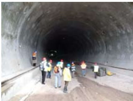
Dálnice D8-A17 - úsek Lovosice-Ústí
